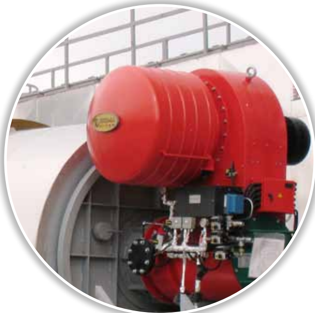
Высокоэффективная моноблочная горелка Highly efficient monobloc burner
